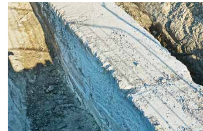
Als Fundament erstellte und der Anschaulichkeit halber freigelegte Erdbeton-Stützwand
