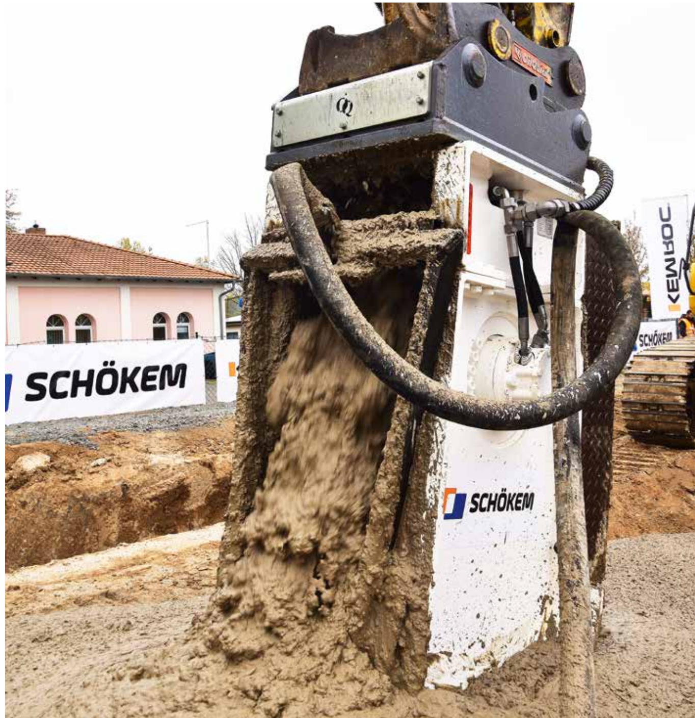
Über einen Förderschlauch und seitliche Injektoren wird die Bindemittel-Suspension zugefügt. Der gewählte Bindemittelanteil bestimmt über Dichtheit und Endhärte des Erdbetonkörpers
