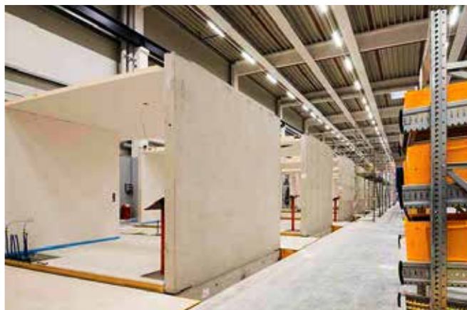
Bei der Autoindustrie abgeguckt: Fertigungsstraße der Maxmodule. 4000 Einheiten pro Jahr können produziert werden
