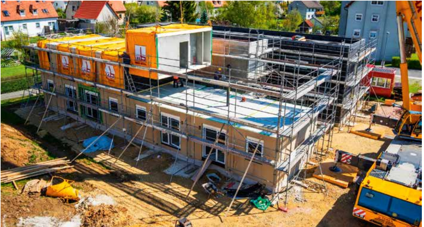
Montage der Module und abschließende Wärmedämmung bei einem der ersten realisierten Projekte
