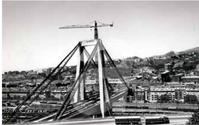
Der Ostpylon mit noch nicht ummantelten Tragseilen
