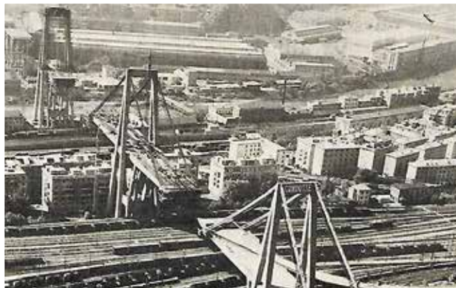
Die Morandi-Brücke bestand aus drei eigenständigen Feldern
