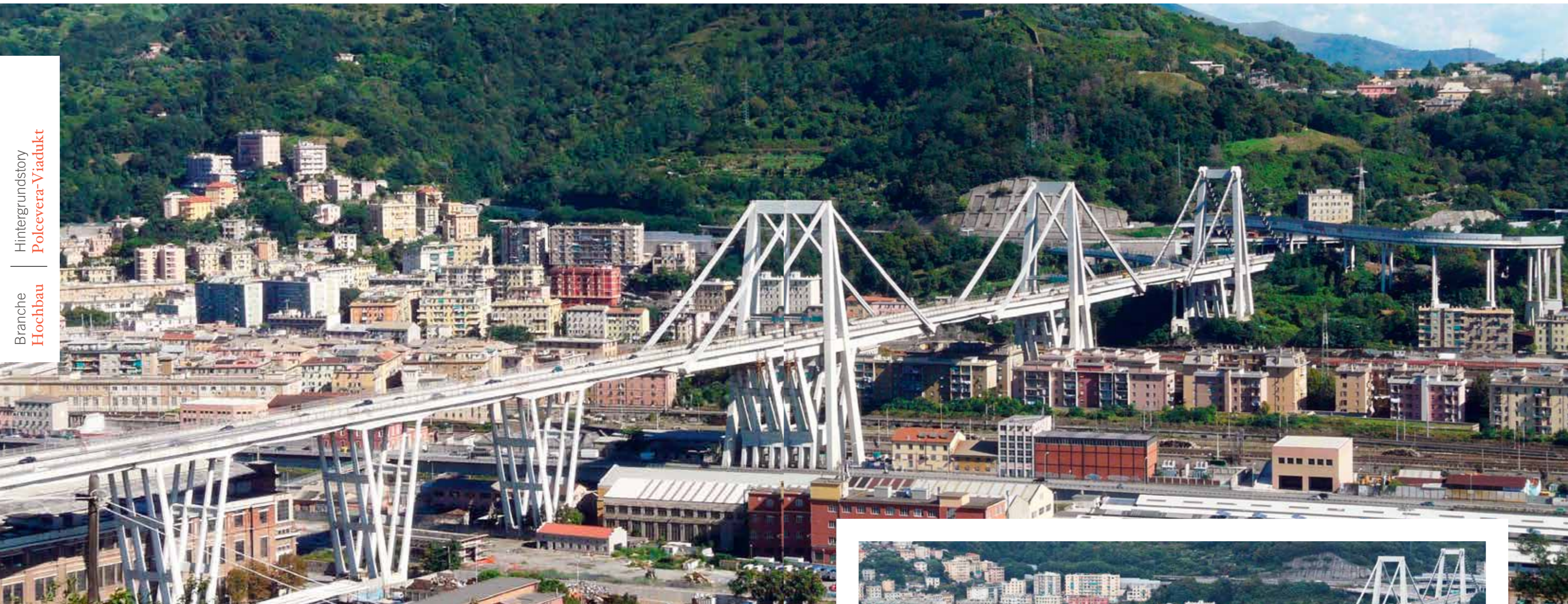
Das Polcevera-Viadukt wurde umgangssprachlich zumeist nach seinem Erbauer Morandi-Brücke genannt
