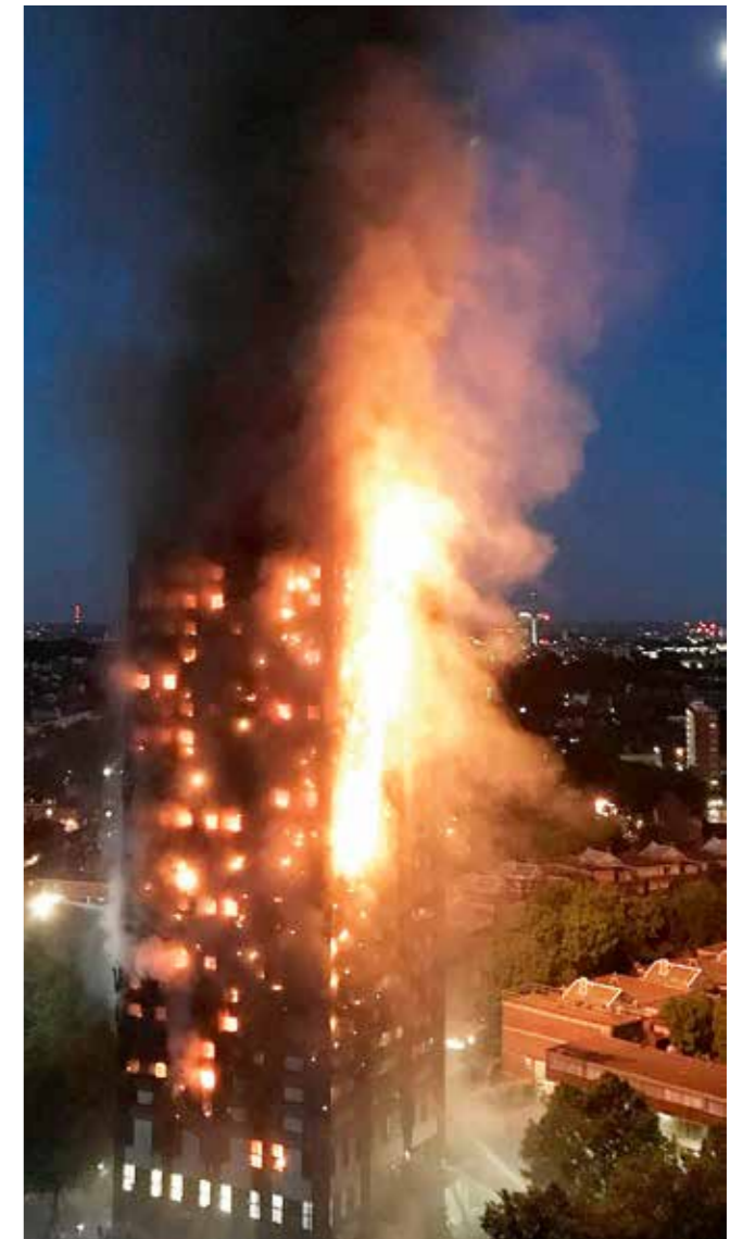
Leider nicht Fiktion, sondern bitterster Ernst: Der 2017 lichterloh brennende Grenfell Tower in London
