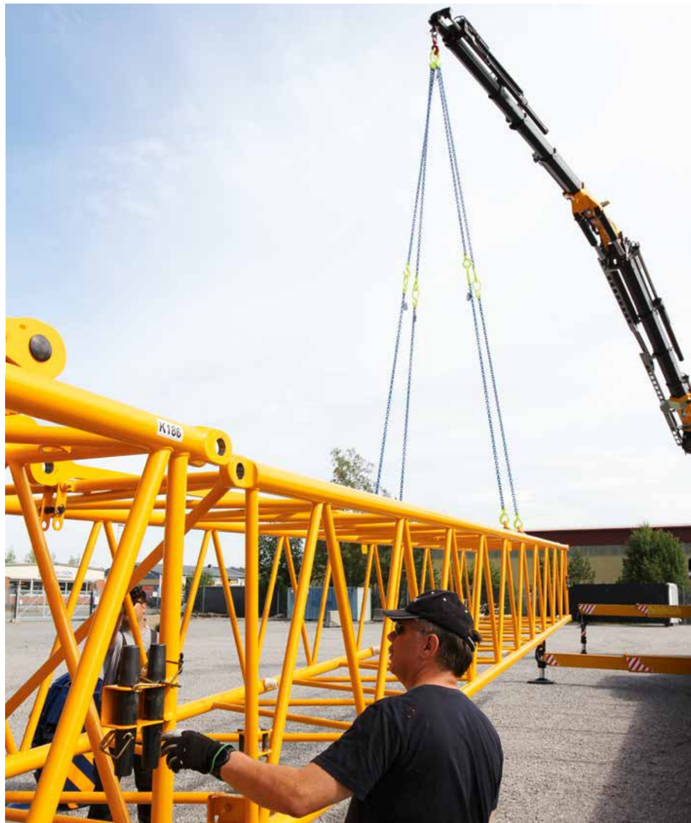
Kranführer Bosse Bizzarina bei der Montage einer 12 m langen Gittermastverlängerung
