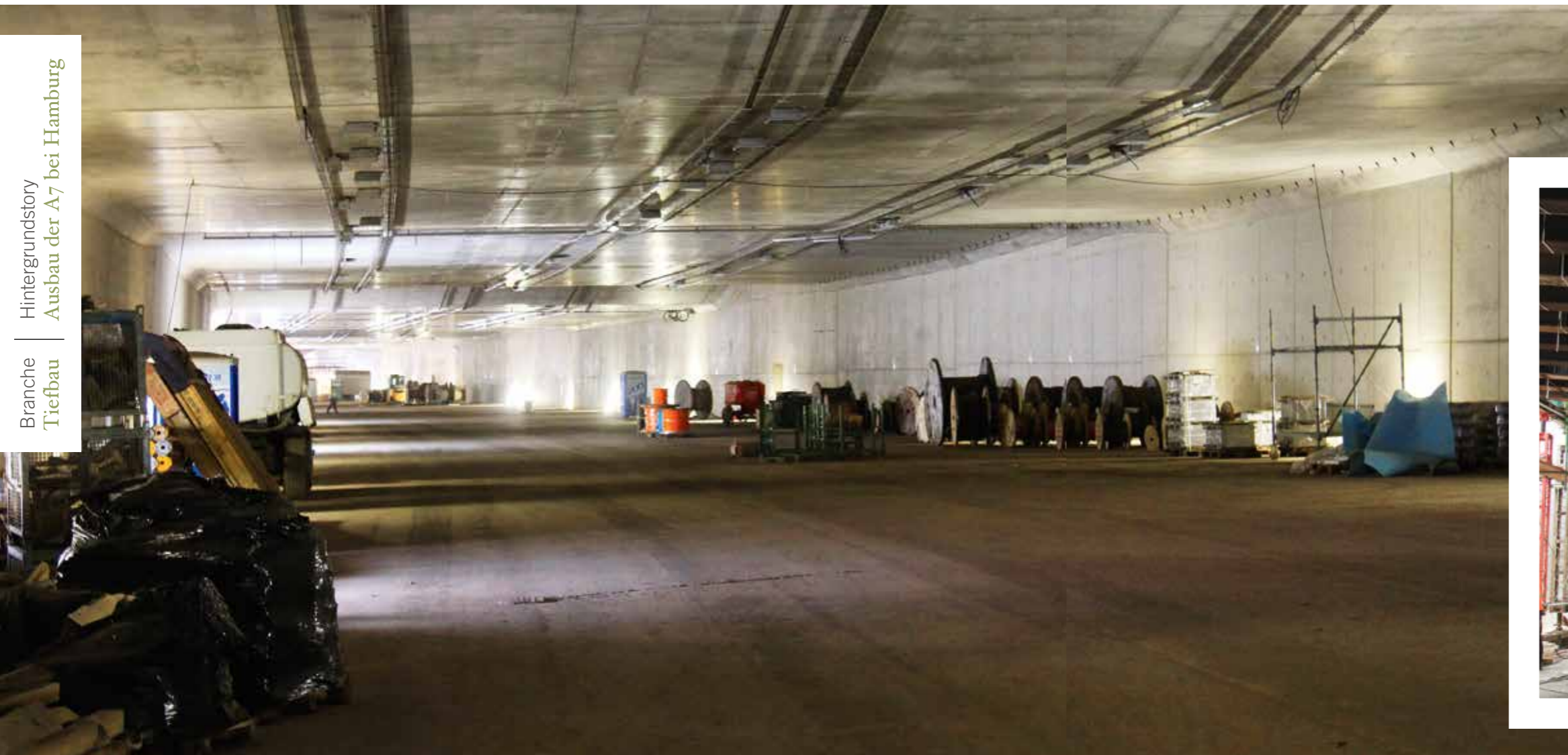
Der Tunnel für die Fahrbahn Richtung Süden im Bereich Stellingen. Hier wird sich in Kürze der gesamte Verkehr der A7 auf sechs verengten Spuren hindurchzwängen. Nach Abschluss der Bauarbeiten wird dann für geplante vier Spuren ausreichend Platz zur Verfügung stehen
