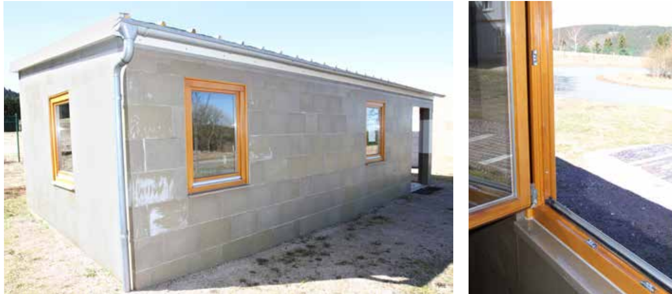
Auf dem Firmengelände errichtetes Demonstrationshaus. Die Detailaufnahme zeigt den präzisen Einbau der Fenster
