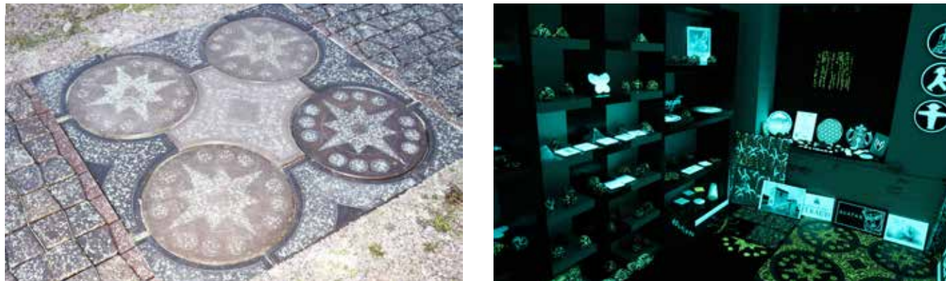
Unterschiedliche Formen von selbstleuchtenden Pflastersteinen eignen sich zur Markierung von nächtlichen Wegen
