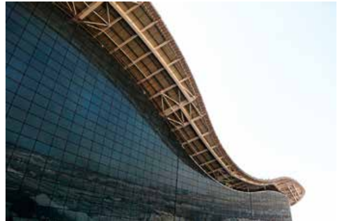
Äuch die Gestalt der Elemente für die doppelt gewölbte Glasfassade wurde vom CAD-Programm berechnet
