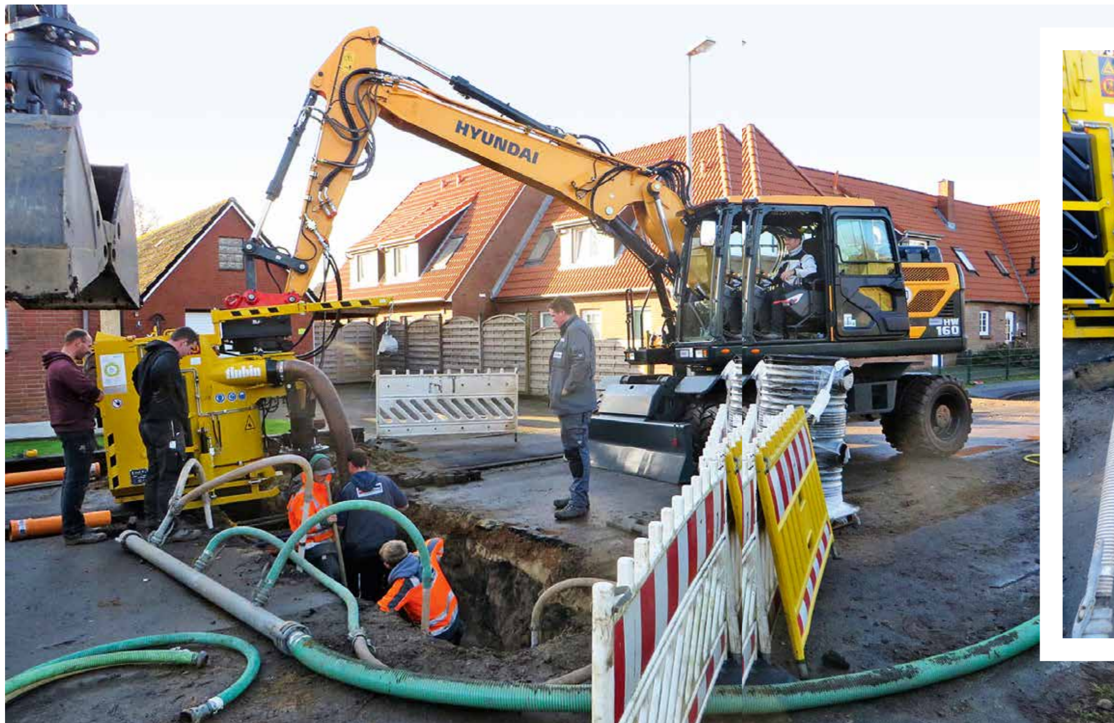
Der BSB-Tinbin-TC2-Saugbaggerlöffel auf einer Baustelle beim Verfüllen einer zuvor freigespülten Baugrube
