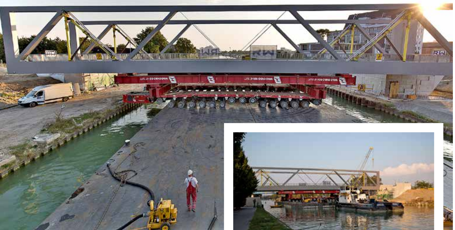
Die neue Brücke wurde auf zwei Pontons eingeschwommen und auf ihre Widerlager abgesetzt
