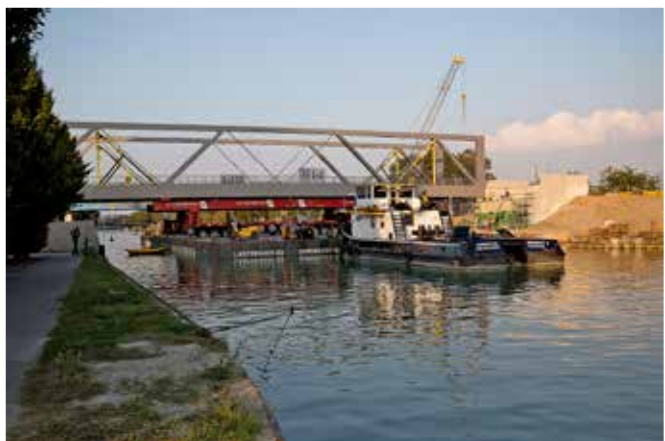
Die neue Brücke wurde auf zwei Pontons eingeschwommen und auf ihre Widerlager abgesetzt
