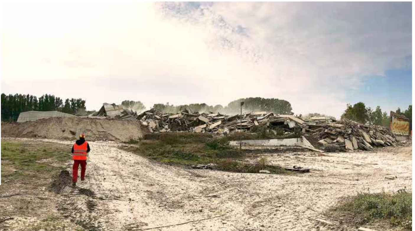
Die Trümmerlandschaft verspricht viel Arbeit für das mit dem Abbruch beauftragte Abbriss-Unternehmen Gertner & Fettback aus Schwielowsee
