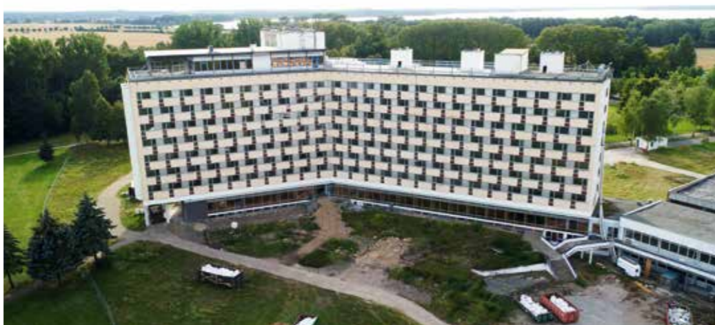
Schon seit 2015 stand das Hotel mit ehemals 1.000 Betten leer. Ein anhängiges Verfahren beim Denkmalschutz verzögerte den Abriss
