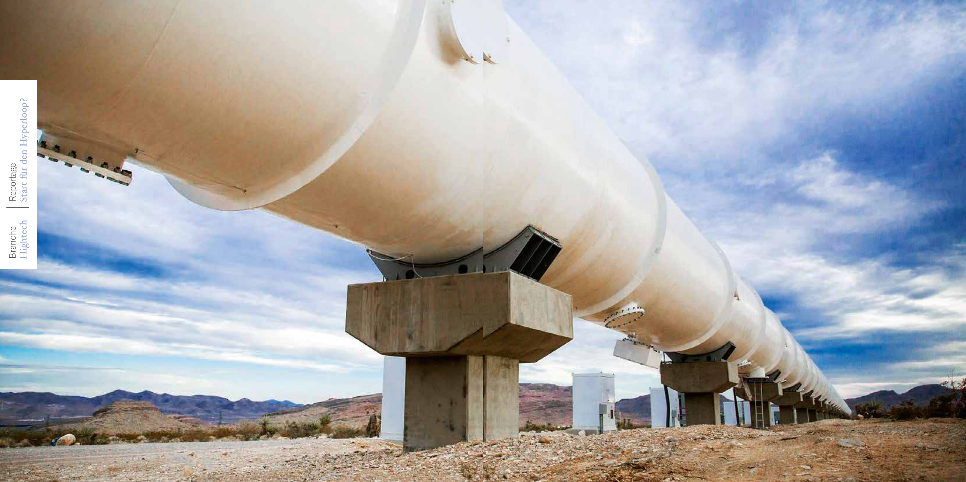
Die SpaceX-DevLoop-Teststrecke nördlich von Las Vegas in der Mojave-Wüste hat einen Durchmesser von 3.300 mm
