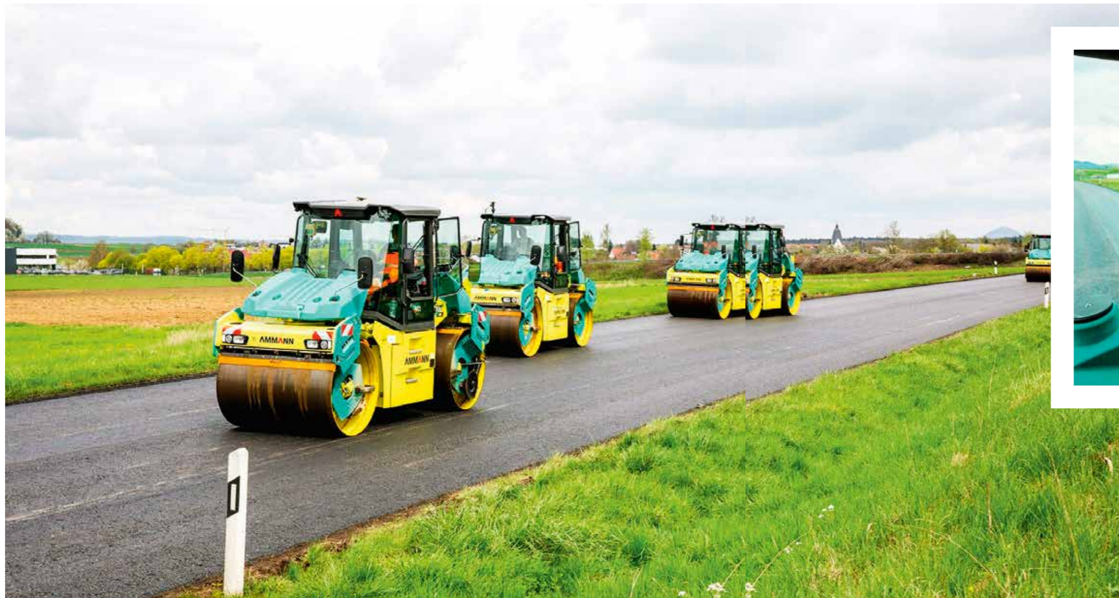
Vier Ammann-Walzen gleichzeitig sorgten beim Projekt „Qualitätsstraßenbau Baden-Württemberg 4.0“ für ideale Verdichtung
